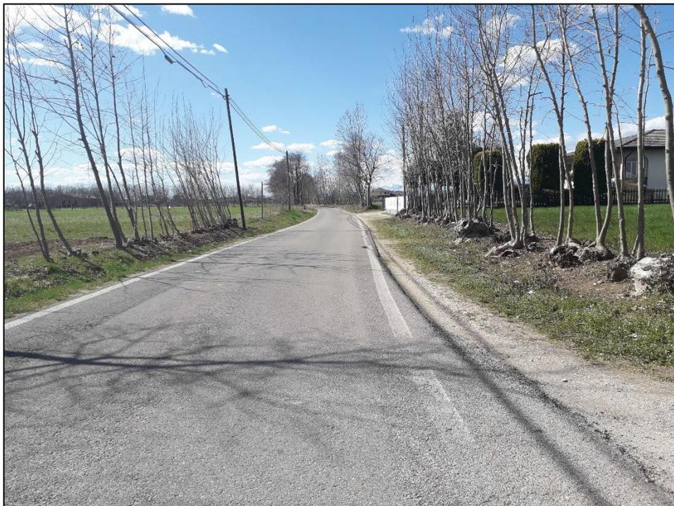
*Figura 16 Esempio di abbassamento del piano campagna stradale rispetto al piano dei campi a causa dell'intensa attività agricola (dettaglio di via Po (Ramon))*
