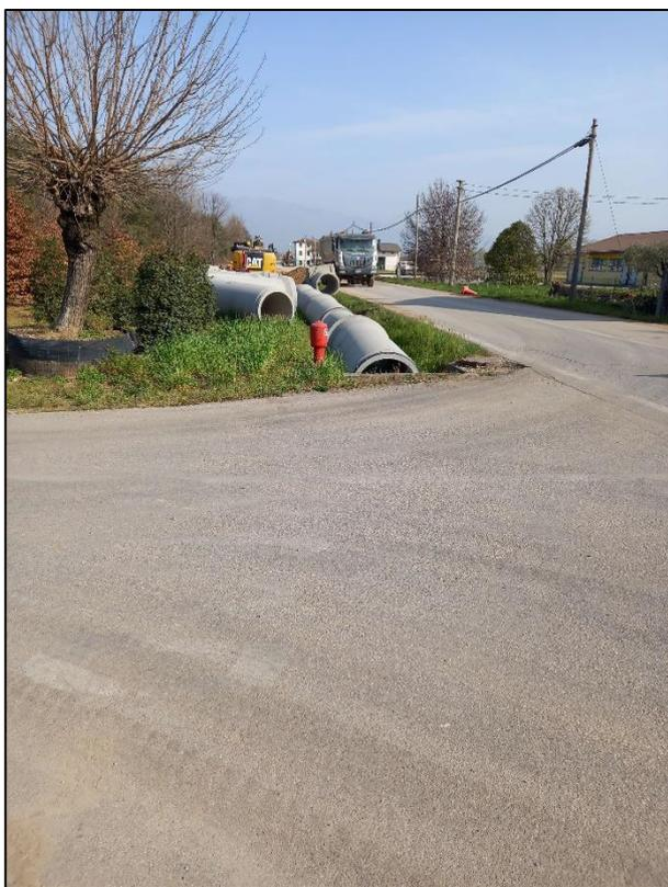
*Figura 22 Foto in cui è possibile osservare i lavori di messa in posa delle condotte dello scarico via Manzolino ramo1*
